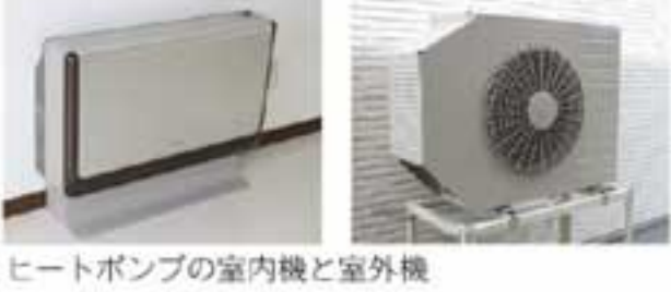
ヒートポンプの室内機と室外機
