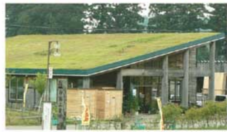
本社事務所屋根の屋上緑化
