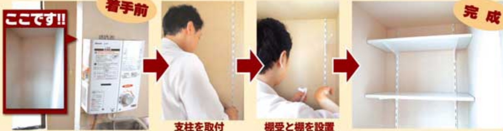
支柱を取付 棚受と棚を設置
