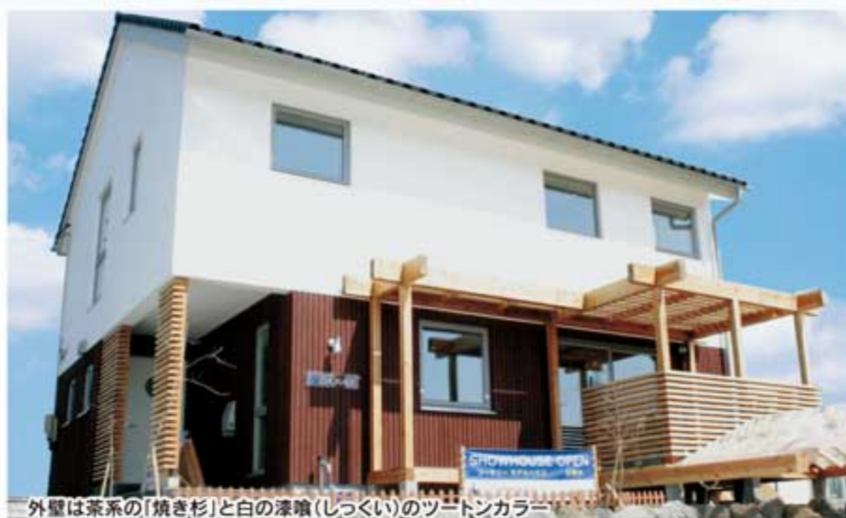
外壁は茶系の「焼き杉」と白の漆喰(しゅくくい)のツートンカラー
