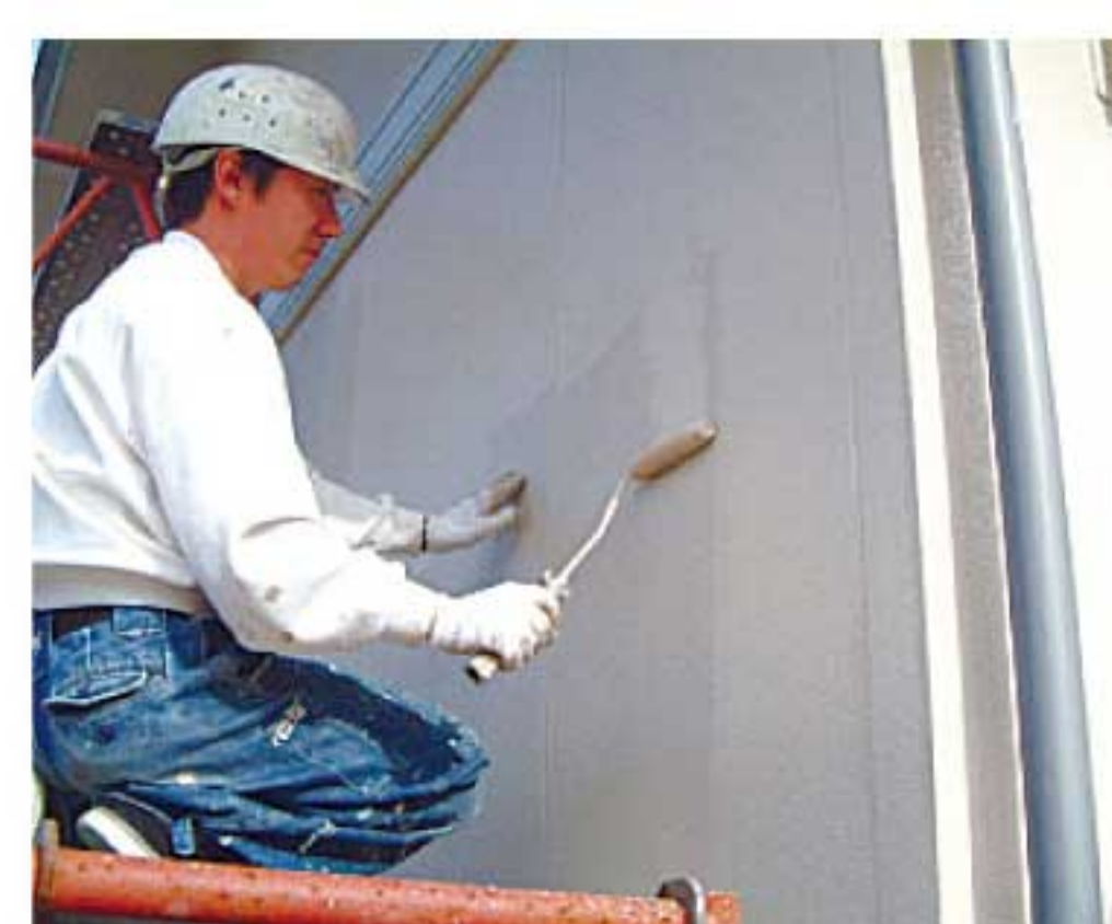
手塗りローラー工法
