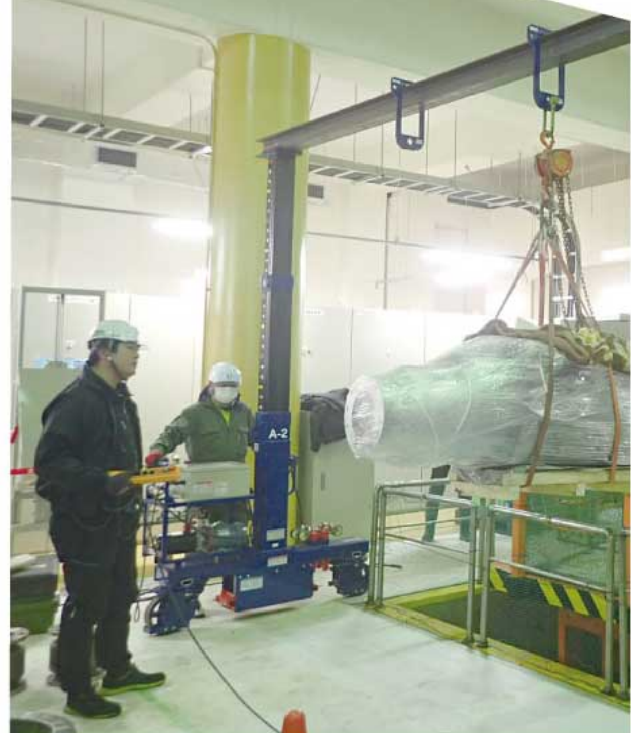
門型クレーンによる ボイラーの吊り上げ作業
