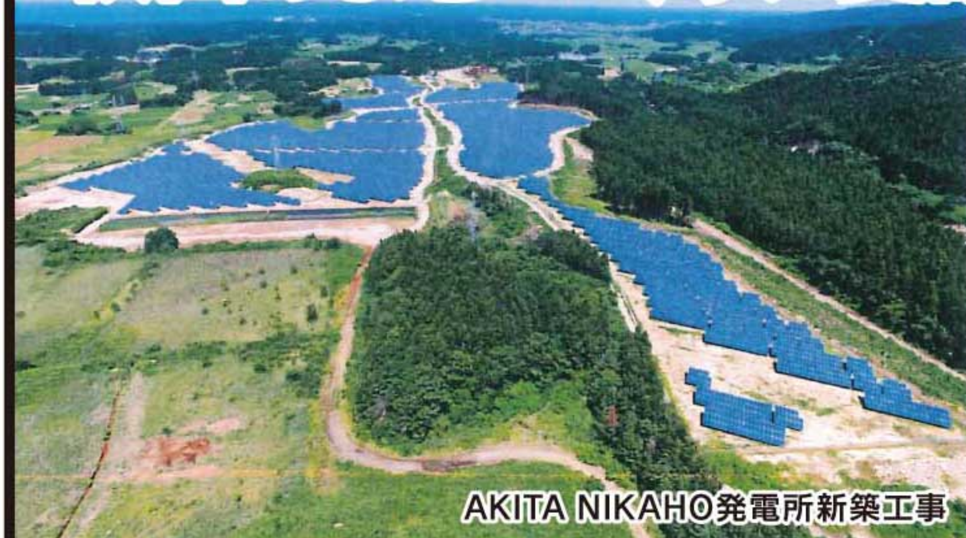
AKITA NIKAH@発電所新築工事
