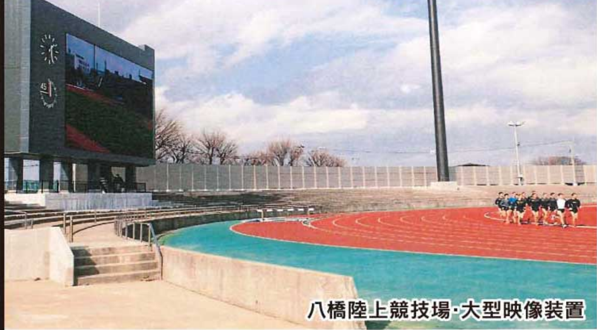
八橋陸上競技場・大型映像装置
