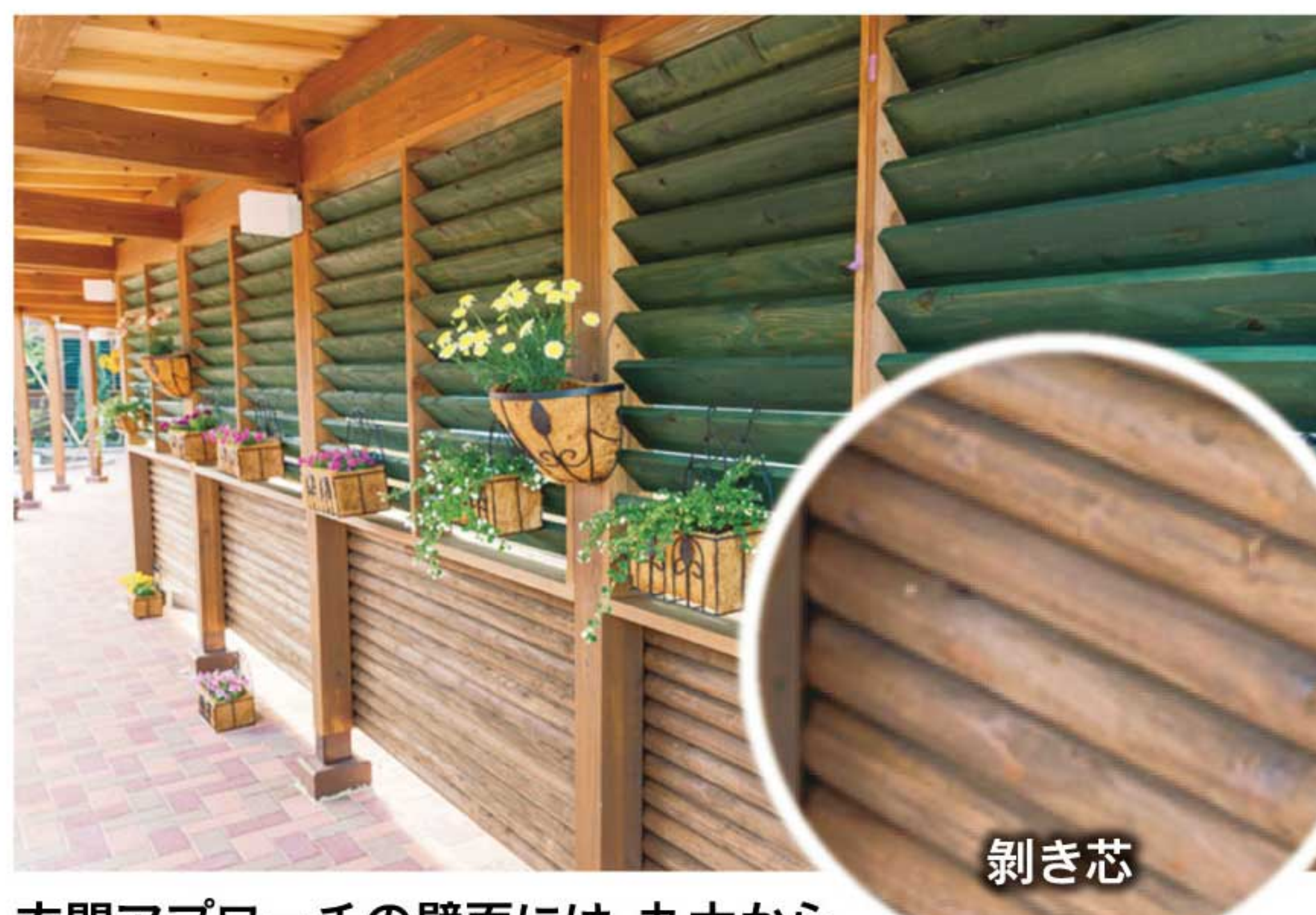
玄関アプローチの壁面には、丸太から合板の材料を剥きとり、最後に残った「剥き芯」を並べて、ログハウス調の風合いのある仕上げを施した。
